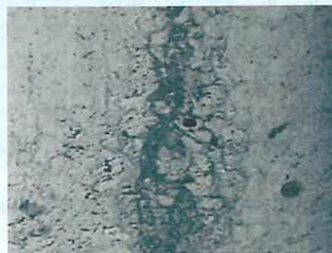
写真 (C) : 鉄筋に砂すじが認められた
