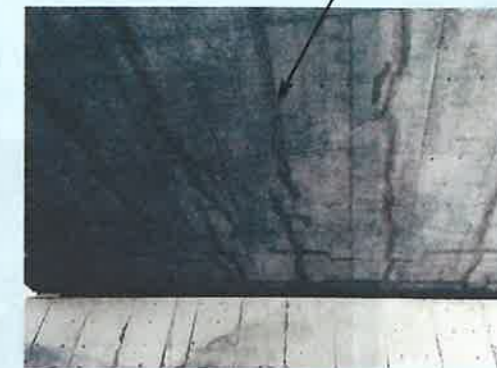
写真2 床版下面の状況
