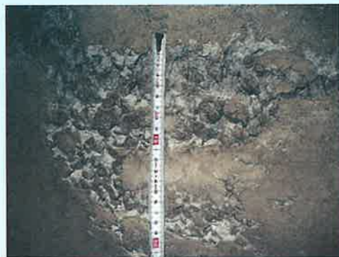
写真 (A) : 豆板部をハンマーで叩いても脱落しなかった
