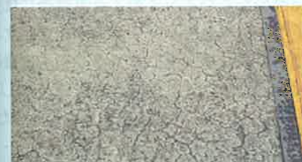
A部の拡大(鉄筋コンクリート床版上面)
