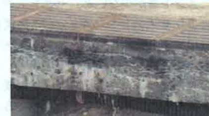
B部の拡大(鉄筋コンクリート床版側面)
