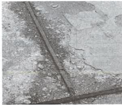
屋上防水の押さえコンクリート
