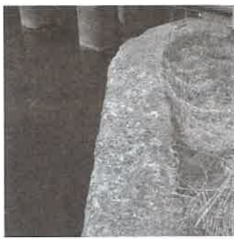
取水口の擁壁
