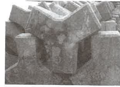
写真B 消波ブロック
