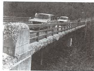
写真A 道路橋地覆
