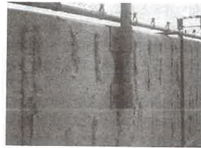
写真C 道路橋壁高欄
