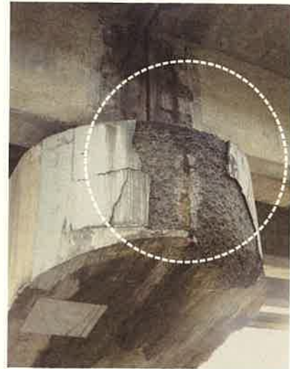
写真2 RC橋脚張出し先端部の状況
