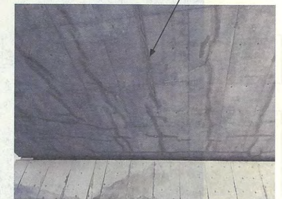
写真2 床版下面の状況
