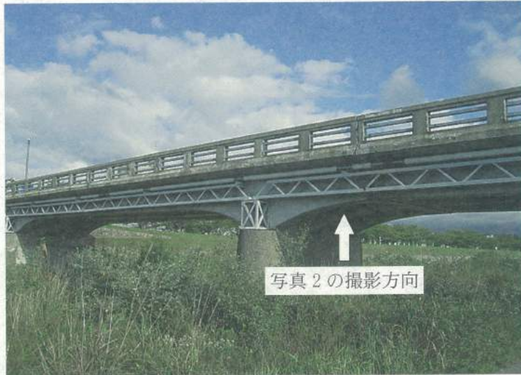
写真1 道路橋の全景
