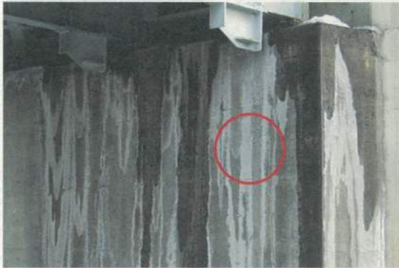
写真(1) 道路橋鉄筋コンクリート橋台の壁面の変色部 (白色物質の主成分：NaCl)
