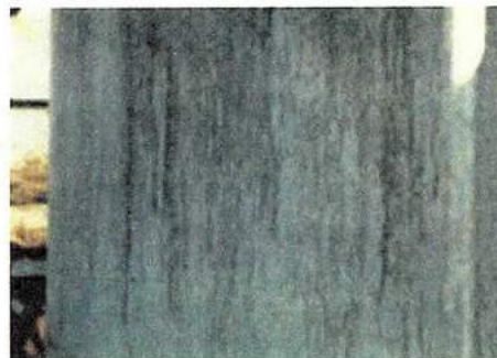
写真D 建物外壁の砂すじ
