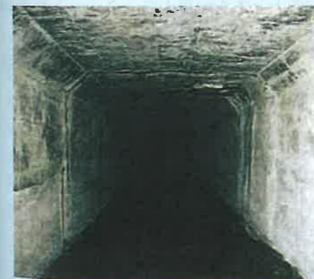
写真1 ボックスカルバート内部の状況
