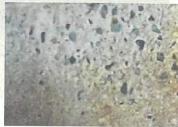
写真1 ボックスカルバート内部の状況 写真2 粗骨材の露出状況
