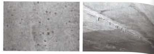
写真-C 直径2~5mmの表面気泡 写真-D スラブ下面に生じたつらら状のエフロレッセンス
