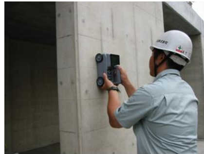
RCLレーダ探査状況
