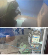
左：ブラスト施工状況
