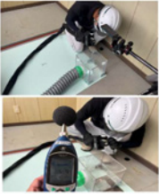
右：レーザー施工状況
