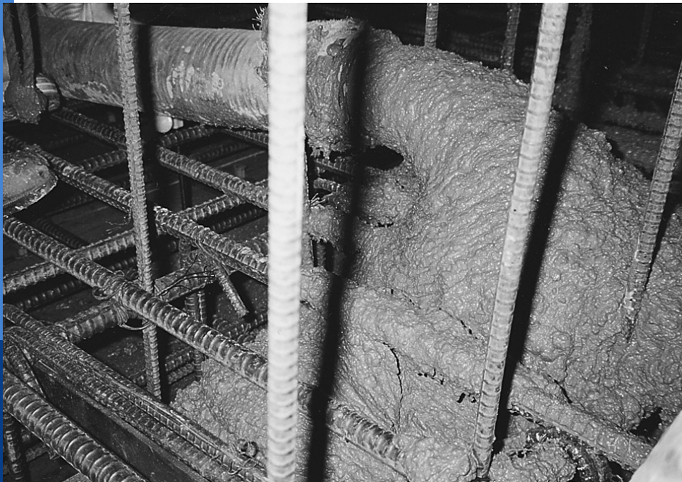
硬練りコンクリート
