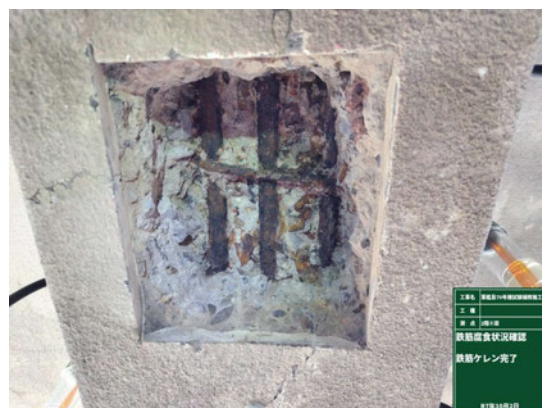
鉄筋腐食状況
