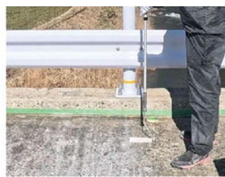
写真 4-3 高浸透型床版防水材料(1層目)塗布工の施工状況
