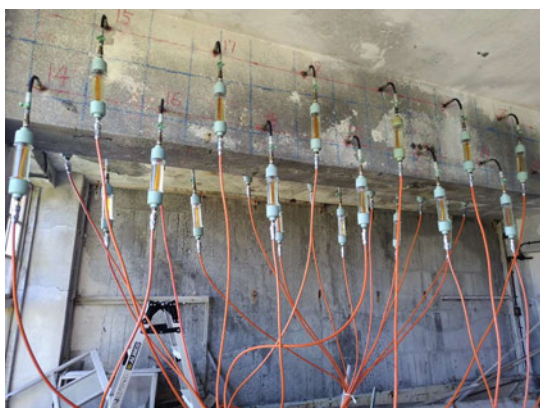
簡易型亜硝酸リチウム内部圧入工「リハビリカプセル工法」 施工状況
