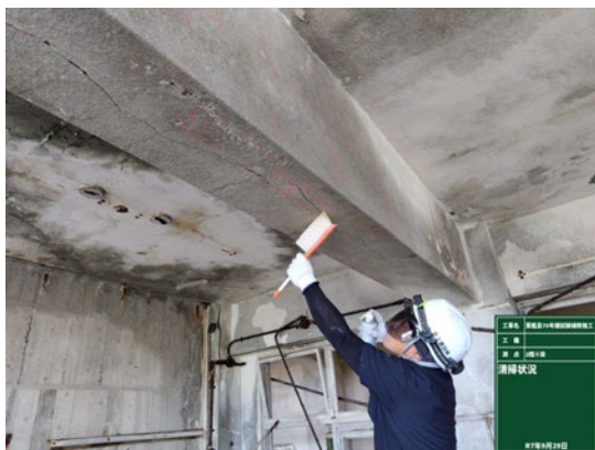
はり下面のひび割れ状況
