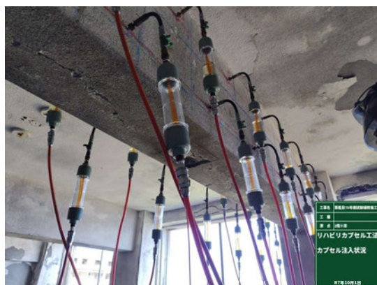
簡易型亜硝酸リチウム内部圧入工「リハビリカプセル工法」 施工状況
