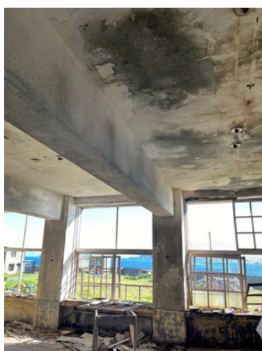
試験施工の対象構造物 2階8通り梁部材
