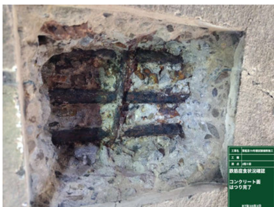
鉄筋腐食状況
