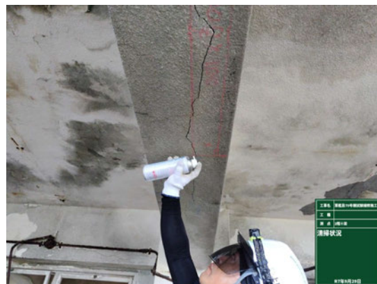
はり下面のひび割れ状況
