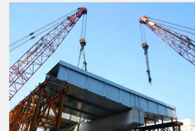
冬場温度が低くて施工ができない
