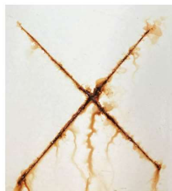
従来弱溶剤形 変性エポキシ樹脂塗料下塗 (60μm×2)
