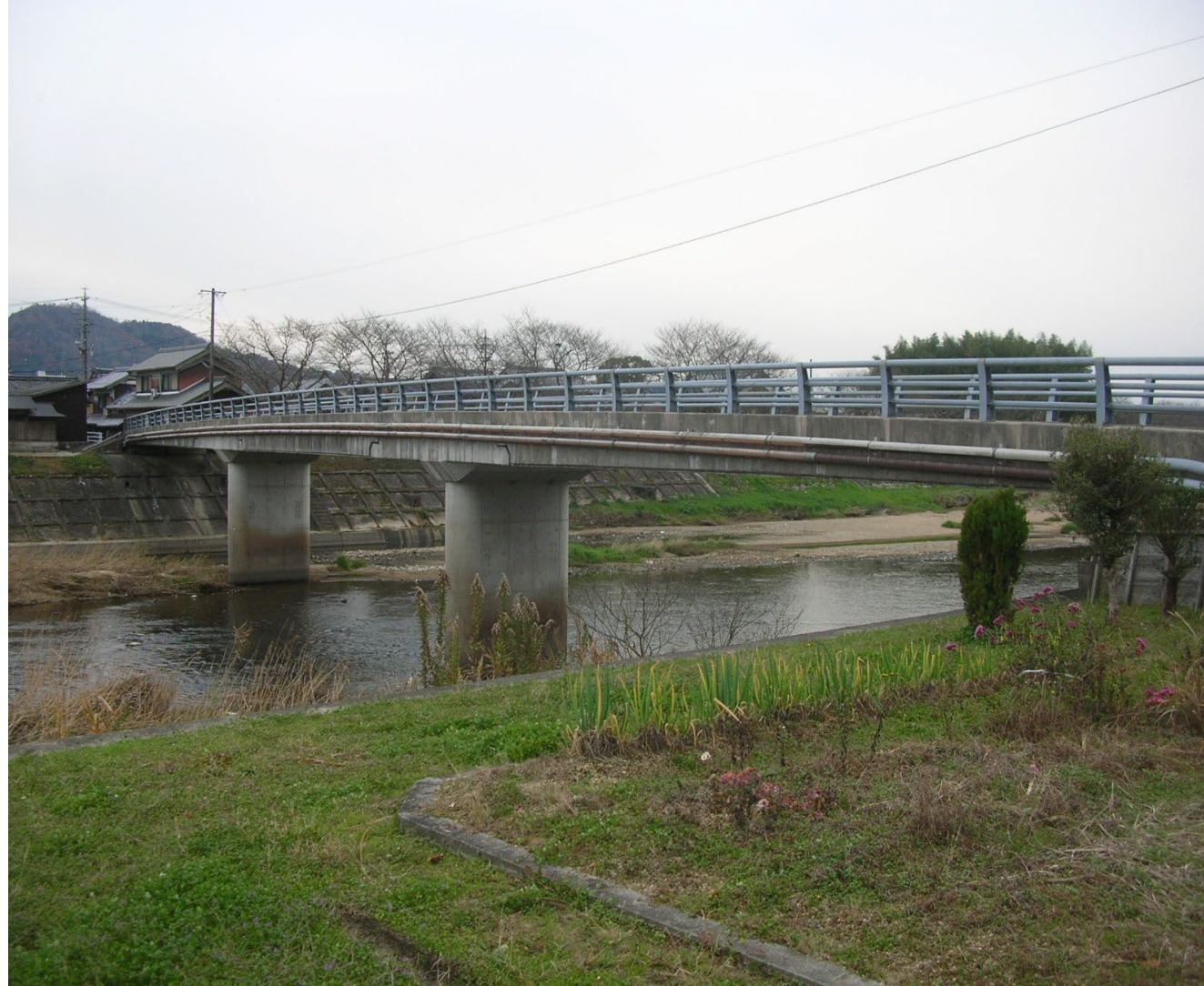
写真1 対象橋梁の全景
