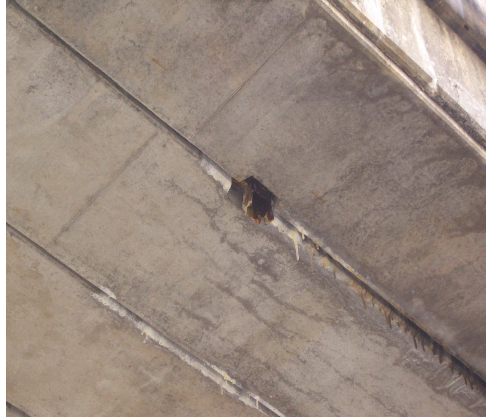
写真3 桁下面の状況
