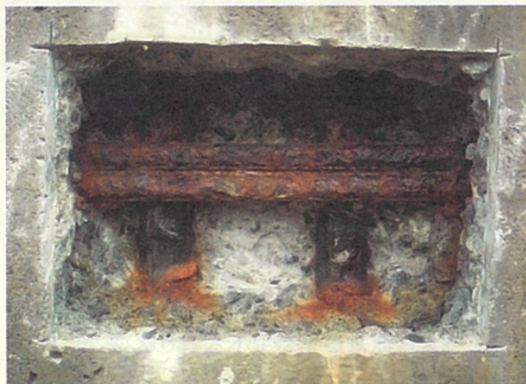
写真2 鉄筋の状態
