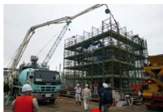
港川高架橋P6 (内割・外割)
