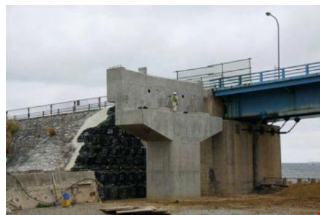
新本部大橋 (下部工：内割・外割)
