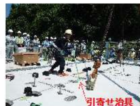
STEP3 引寄せ治具による床版架設
