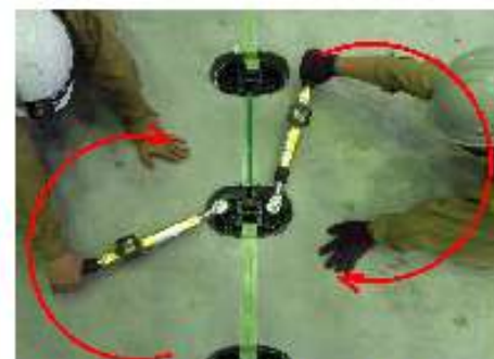
STEP6 ボルト締付 (トルク導入)
