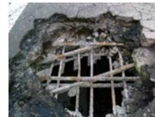
RC床版の押抜きせん断破壊
