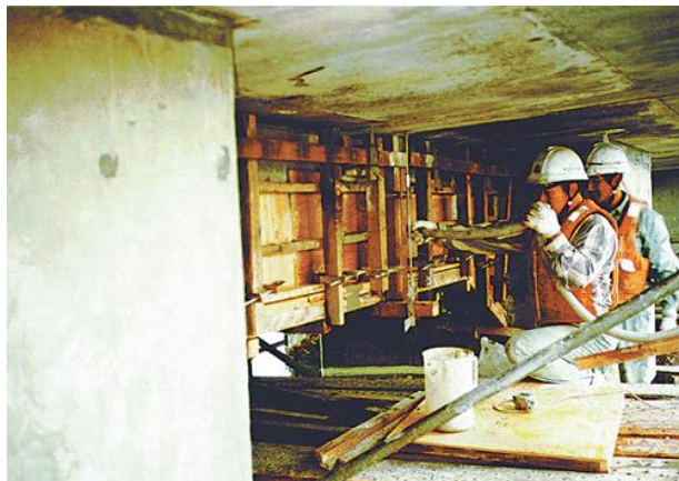
【側面充てんの施工】
