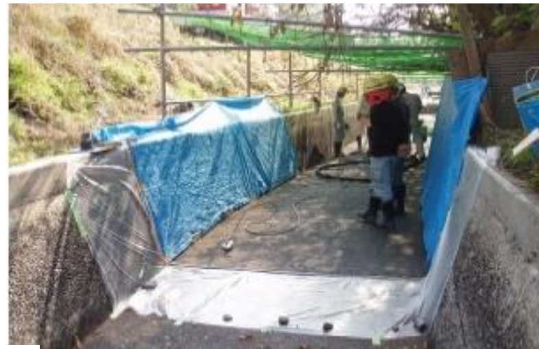
〔シート養生状況〕
