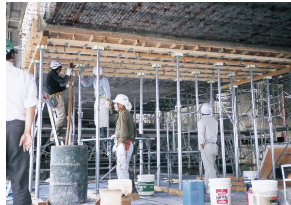
【下面充てんの施工】
