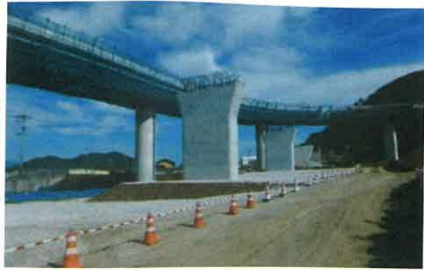
写真1 温度ひび割れ対策として フライアッシュを用いた橋脚 2)
