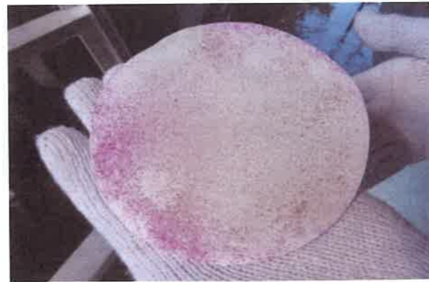
写真5 中性化深さ試験状況(ドリル法)
