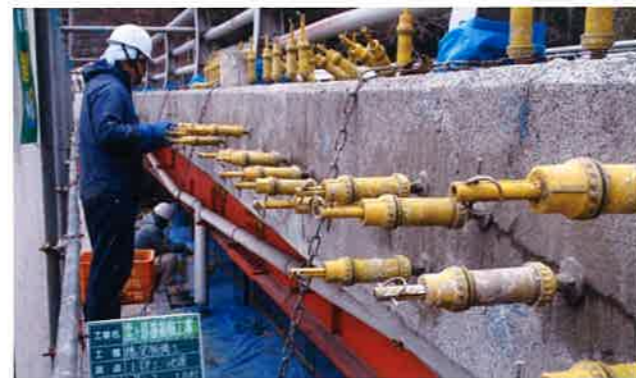
写真-1 ひび割れ注入工法の施工状況
