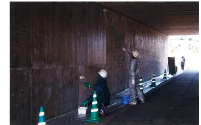
写真-3 表面含浸工法の施工状況
