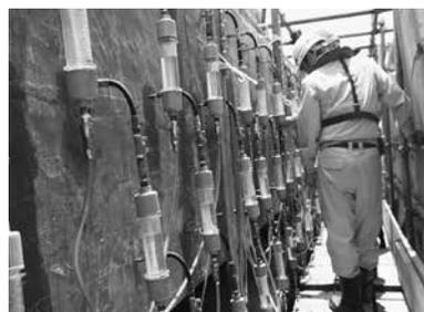
写真3 亜硝酸リチウム内部圧入工法の施工状況
