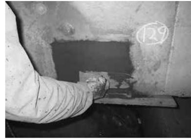
写真5 亜硝酸リチウム併用型断面修復工法の施工状況
