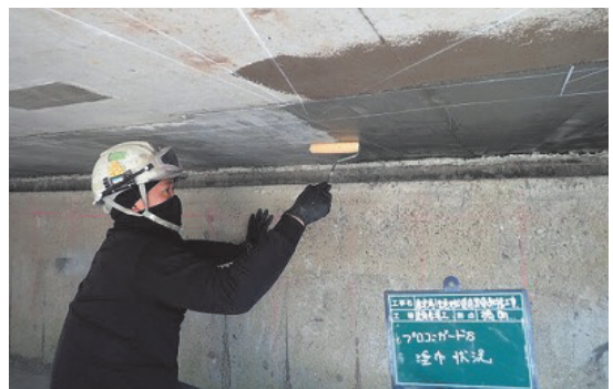
写真-3 亜硝酸リチウム併用型表面含浸工法の施工状況
