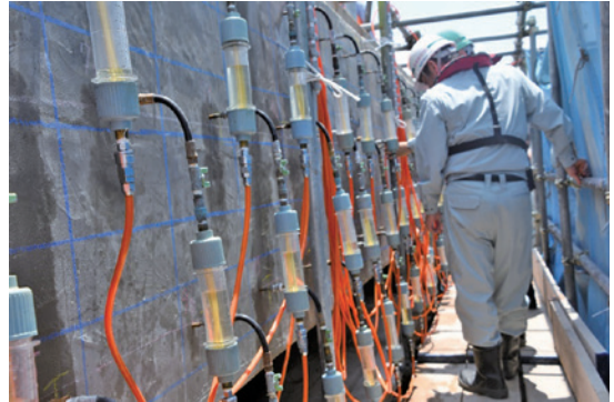
写真-6 亜硝酸リチウム内部圧入工法の施工状況
