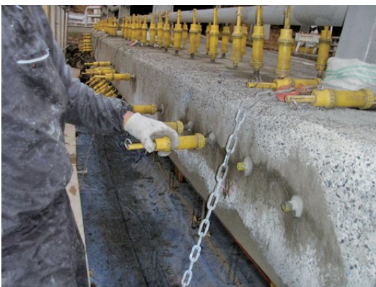
写真-4 亜硝酸リチウム併用型ひび割れ注入工法の施工状況
