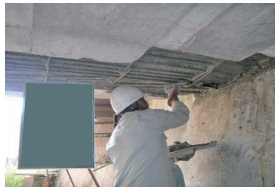
写真-5 亜硝酸リチウム併用型断面修復工法の施工状況
