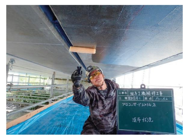
写真-1 表面含浸工法の施工状況
