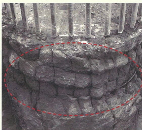
写真 杭頭上部のコンクリートの充填不良
