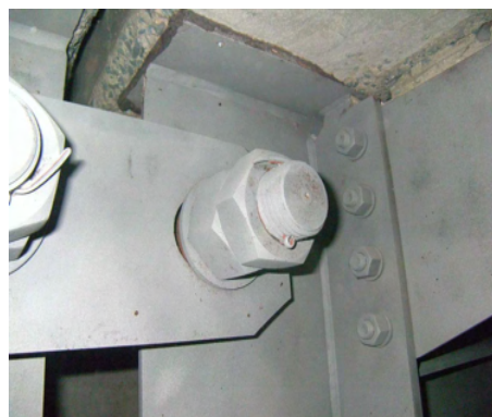
ブラスト施工後
