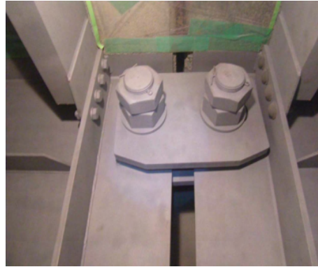
ブラスト施工後
