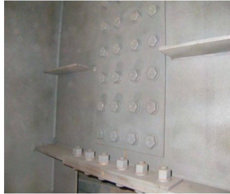
ブラスト施工後
