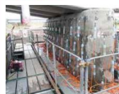
リハビリカプセル工法施工状況
