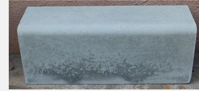
劣化発生 → 応急処置として現場で刷毛でシラン系含浸剤を塗布
