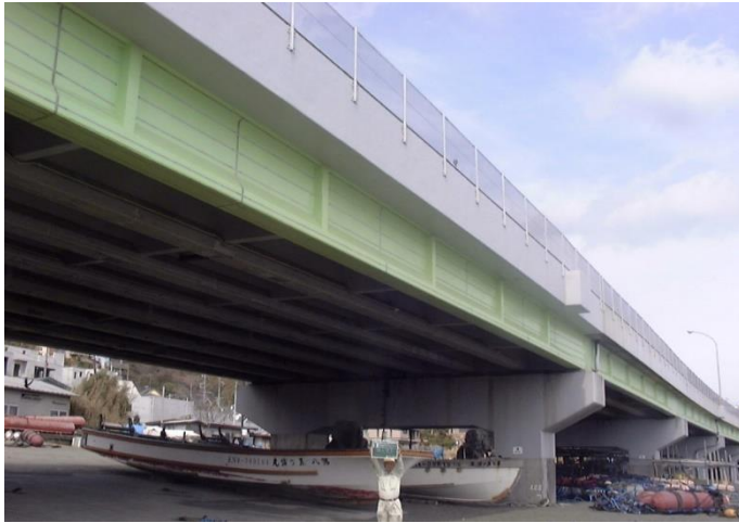
橋梁構造物への適用事例
