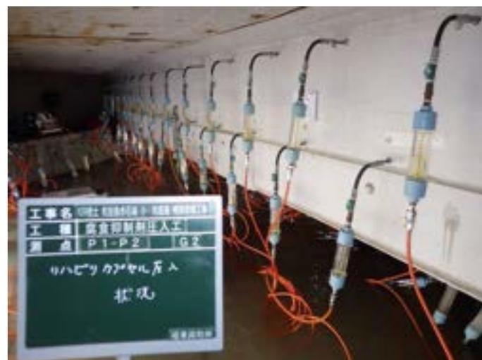
鋼板接着を残してリハビリカプセル工法
