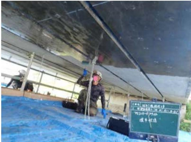
**REHABILI** 亜硝酸リチウムとシラン・シロキサン系表面含浸材を併用した塩害・中性化・ASR補修技術
