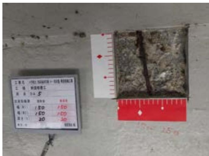
過去の塩害補修が再劣化
