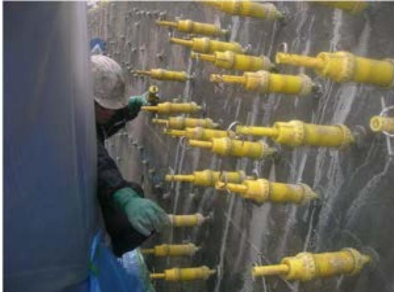
**REHABILI** 浸透拡散型亜硝酸リチウム40%水溶液『プロコン40』を用いた塩害・中性化・ASR補修技術 特許第30110017号
