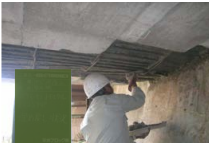
部分断面修復工
