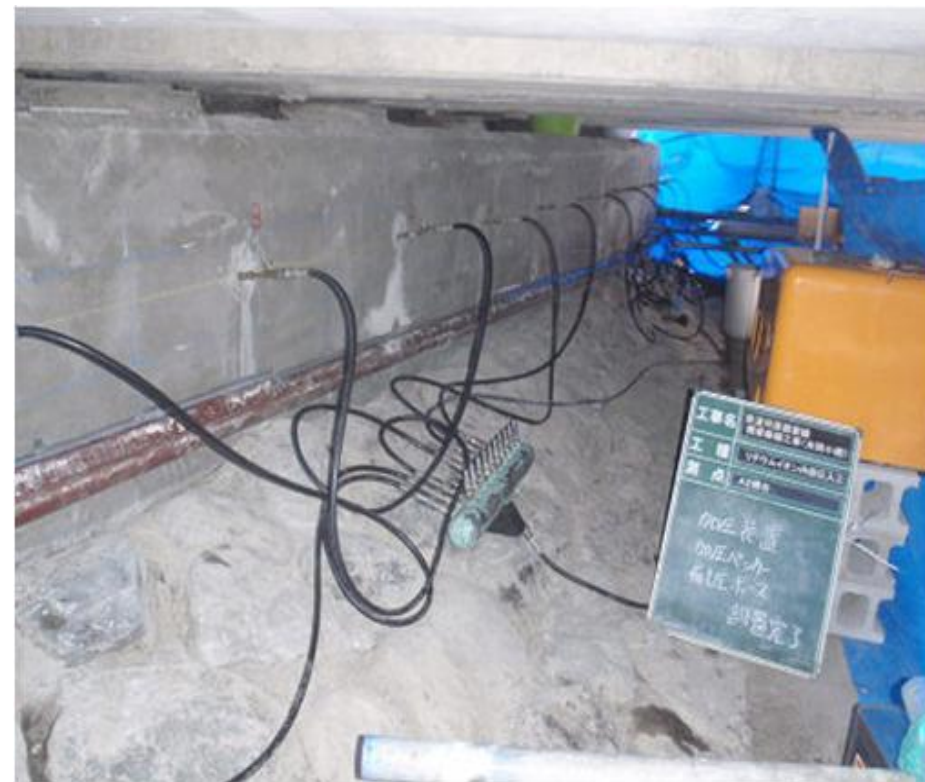
亜硝酸リチウム内部圧入工法
