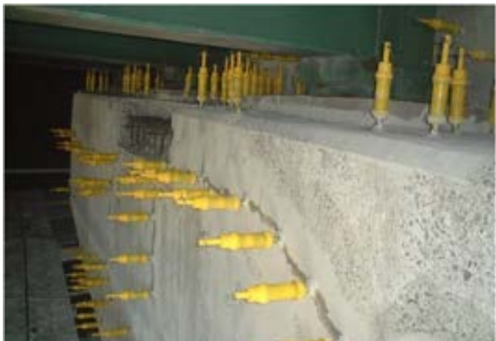
ひび割れ注入工
