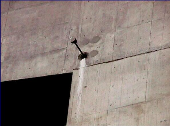
横締めPC鋼棒の破断
