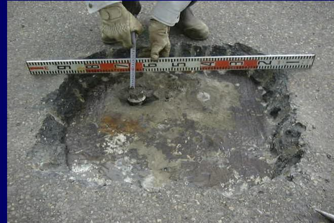
鉛直締めPC鋼棒の破断
