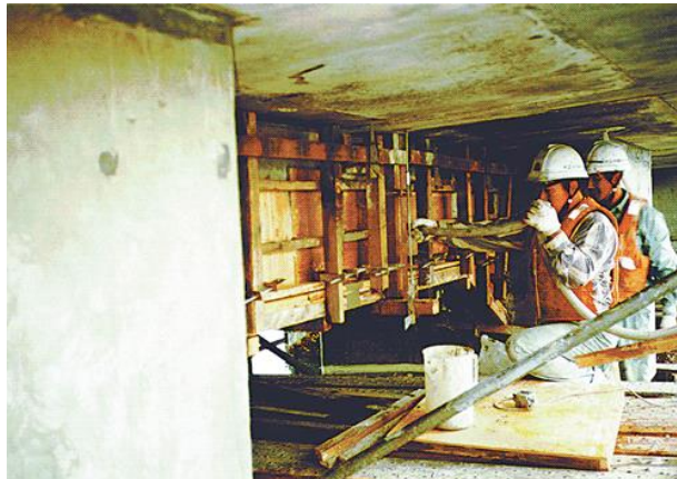
【側面充てんの施工】
