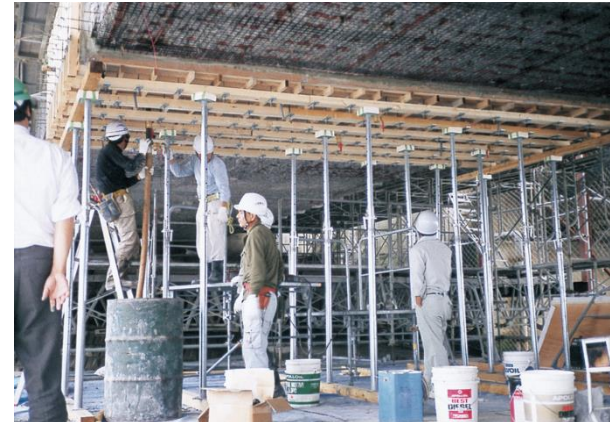
【下面充てんの施工】
