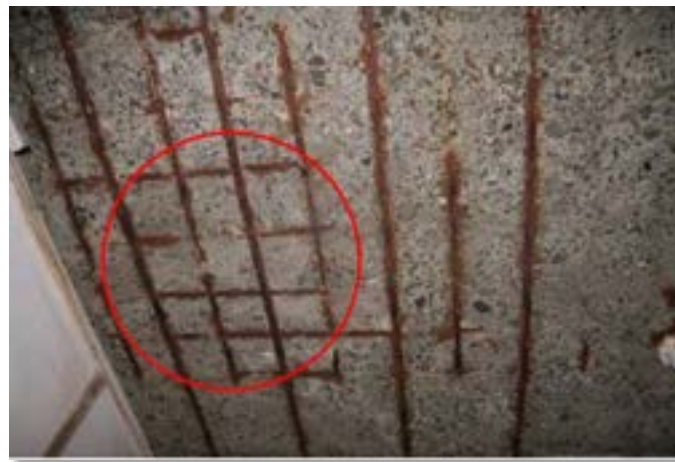
コンクリートの剥落・鉄筋の露出
