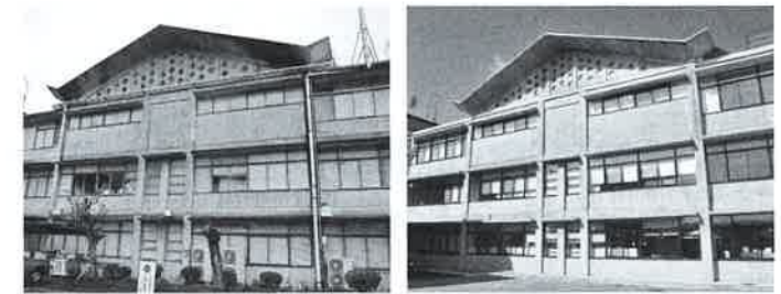
写真3 歴史的建築物の中性化補修事例
