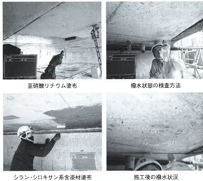
写真2 橋梁上部工の塩害補修事例
