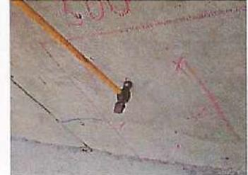
(3)クラックスケール、コンベックスを使用し、ひび割れ幅・長さの測定を行う。
