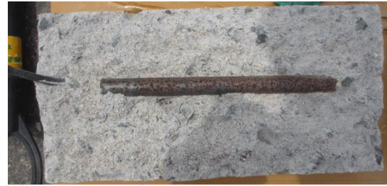
写真－1 初期の鉄筋腐食状況
