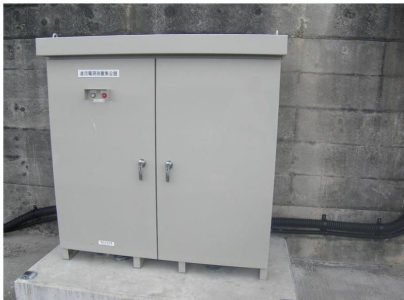
8回路用直流電源装置の例
