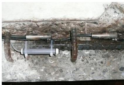
排流・測定用端子を溶接する。照合電極を鋼材の近傍に設置する。
