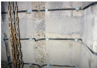
陽極を埋込むために溝切りを行う。陽極・コンダクターバーを設置し修復材で埋戻す。
