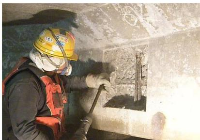
マーキング位置のコンクリートをはつり出し鋼材を露出させる。
