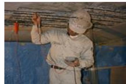
マルチメータを用いて排流線と鋼材間の導通を確認し、1mV以下であれば合格。
