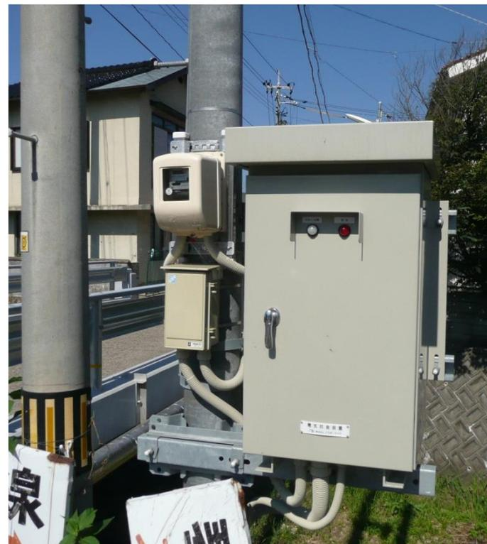
1回路用直流電源装置の例
