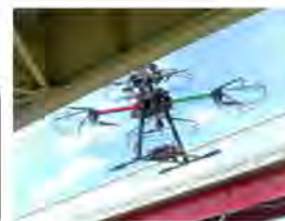
ドローンによる損傷把握
