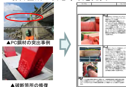
▲破断箇所の修復
