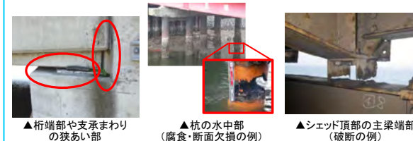
▲桁端部や支承まわりの狭あい部
