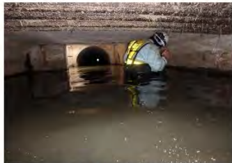
滞水した溝橋内部の目視点検
