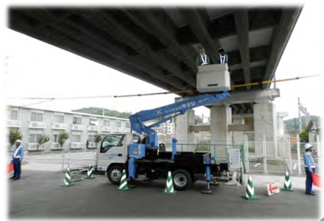
近接目視による損傷、劣化、その他の異状の捕捉あるいは把握
