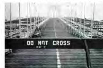
ケーブル切断事故後、通行止めたブルックリン橋の歩道 （「高速道路と自動車」1981年11月から引用）
