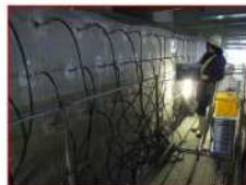
亜硝酸リチウム内部圧入工施工状況（参考写真）
