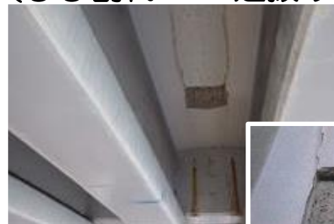
④間詰め部 (ひび割れ→Co辺抜け落ち)
