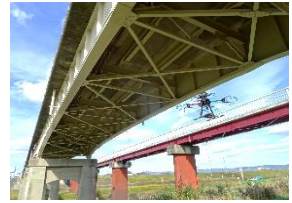
橋梁の損傷写真を 撮影する技術
