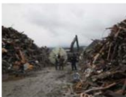
（東日本大震災における道路の啓開状況）
