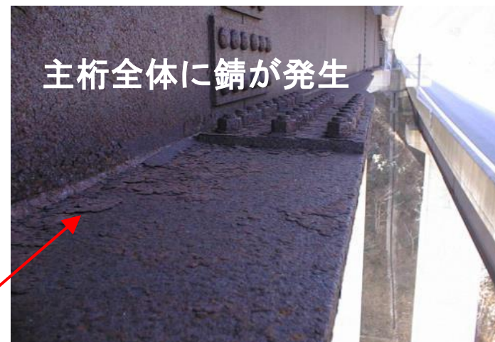
鋼橋(耐候性鋼材使用)
