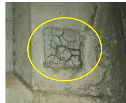
④間詰め部 (ひび割れ→Co辺抜け落ち)
