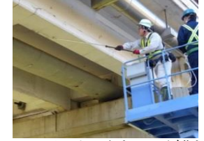
コンクリートのうき・はく離を 非破壊で検査する技術
