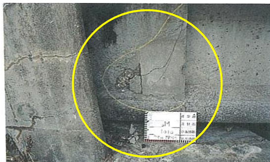
①桁端部のひび割れ
