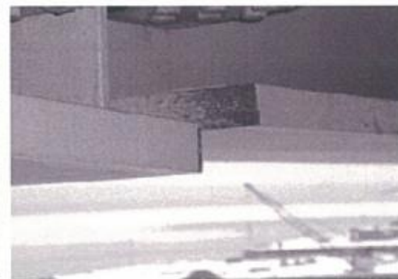
2000.12 ▲ミルウォーキー州ホーン橋 鋼主桁の亀裂による路面沈下
