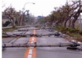
（台風による道路の被災状況）
