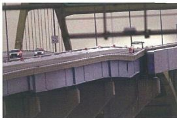
2000.12 ▲ミルウォーキー州ホーン橋 鋼主桁の亀裂による路面沈下
