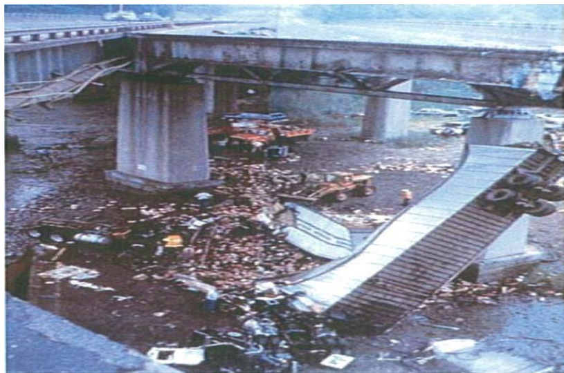
1983 ▲コネチカット州 マイアナス橋の落橋
