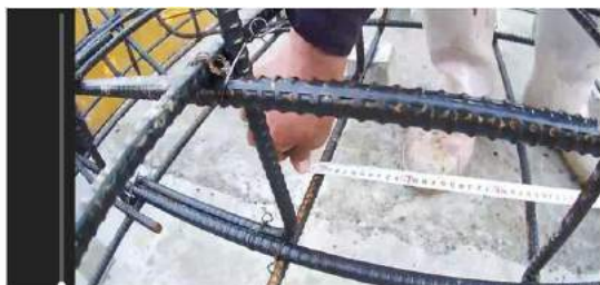
鉄筋の配筋間隔を拡大し検測
