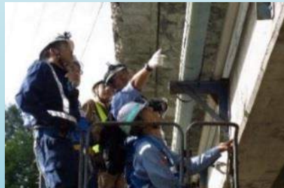
▲橋梁に対する診断
