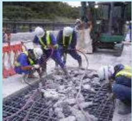
▲修繕・耐震補強
