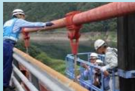
▲国道メンテナンス
