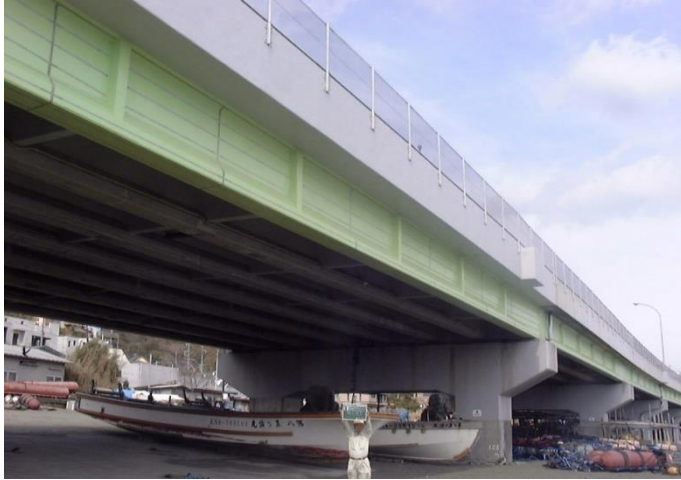
橋梁構造物への適用事例
