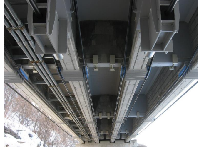
橋梁・補強と併用の例
