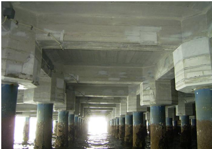
栈橋構造物への適用事例
