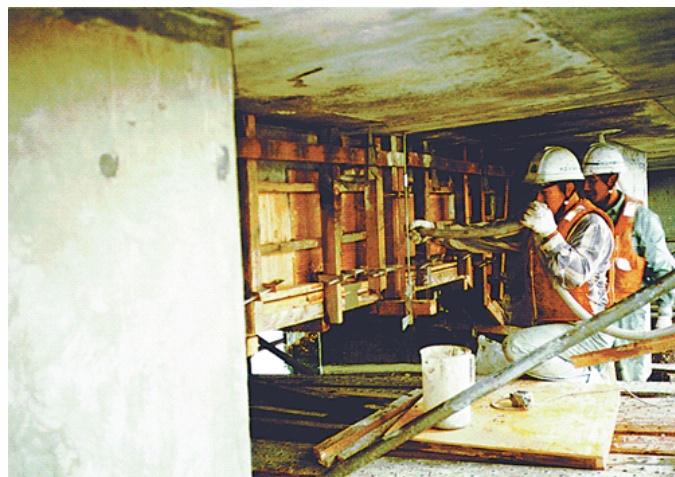
【側面充てんの施工】
