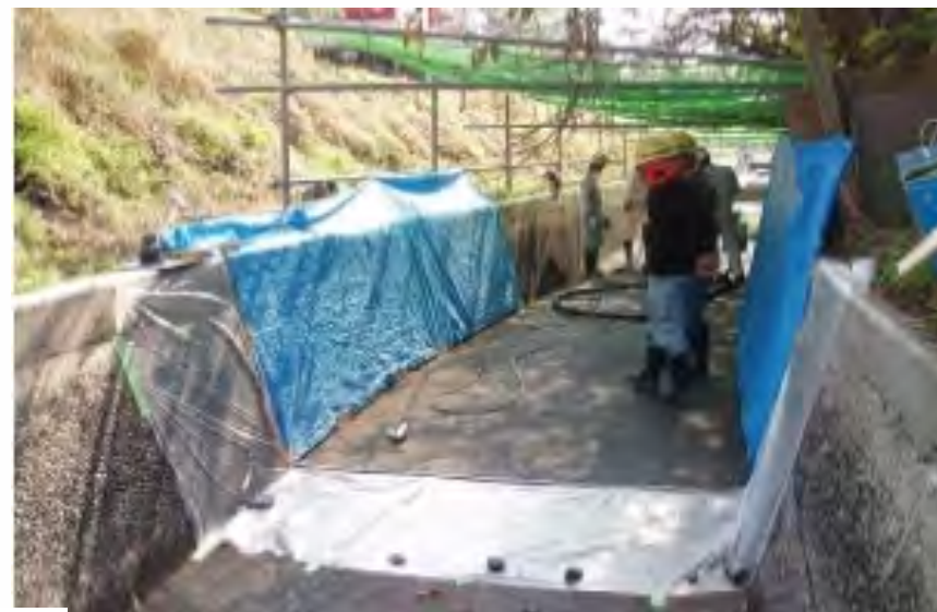
〔シート養生状況〕
