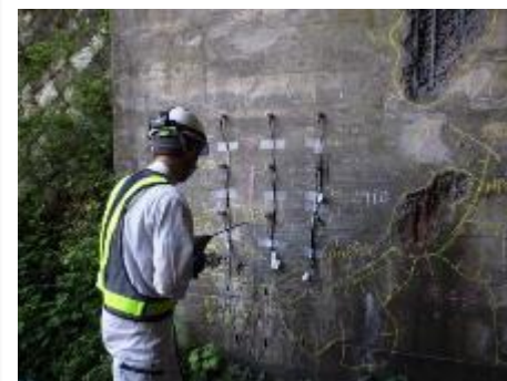
図- ドリル削孔状況
