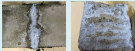
ひび割れ部位の注入後の表面
