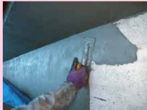
⑤表面被覆工法 『リハビリ被覆工法』
