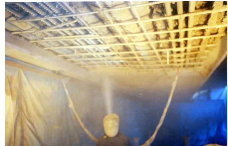
全断面修復工法
