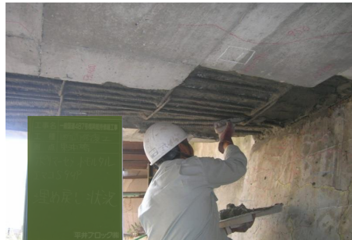
部分断面修復工
