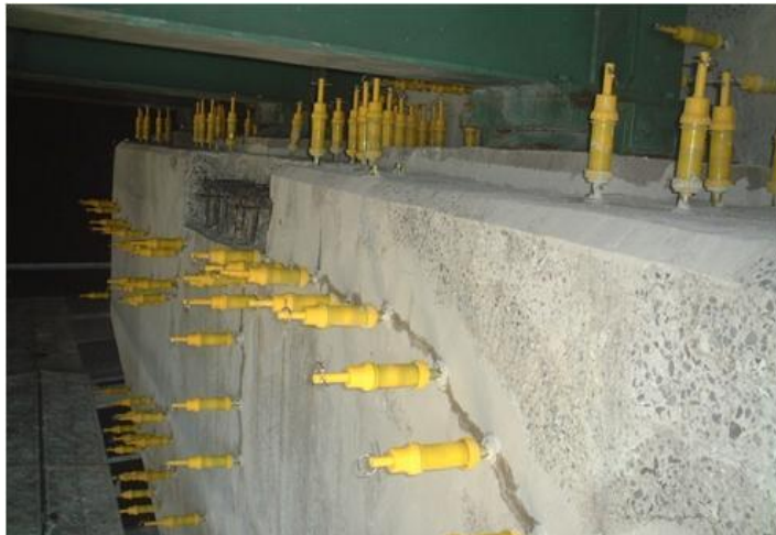
ひび割れ注入工
